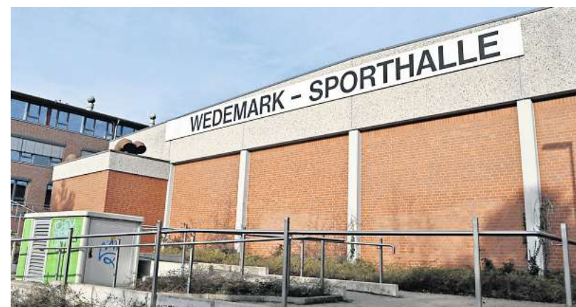
Die Wedemark-Sporthalle auf dem Campus W in Mellendorf benötigt dringend eine Sanierung.
